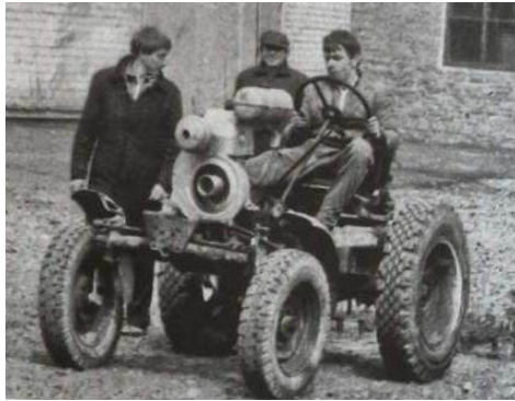
Рис. 6. Студенти відділення випробовують власноруч виготовлений експериментальний міні-трактор
